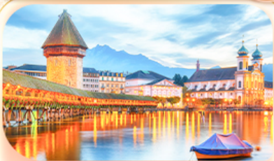
สะพานไมซ์าเปค
