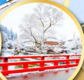
สะพานนากะบาชิ
