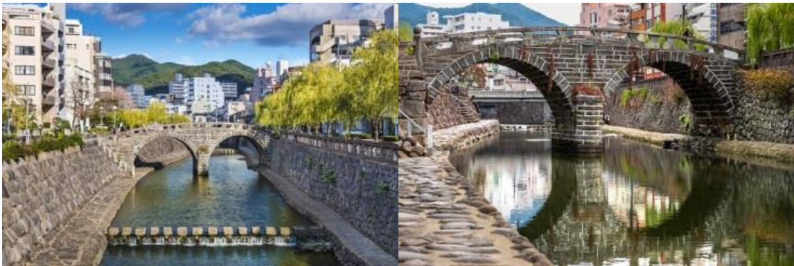
สะพานเมกานะบะชิ (Meganebashi Bridge)
