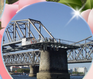
สะพานขาดตานตง
