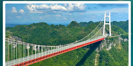
สะพานอายจ้าย
