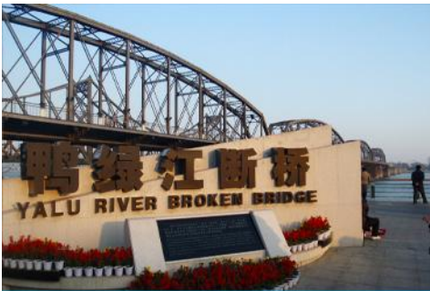
สะพานขาด
