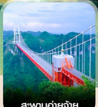
สะพานอ้ายจ้าย
