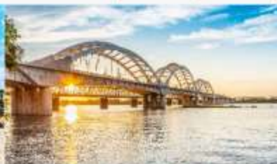
สะพานรถไฟ
