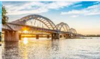
สะพานรถไฟ
