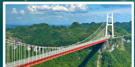
สะพานอ้ายจ้าย
