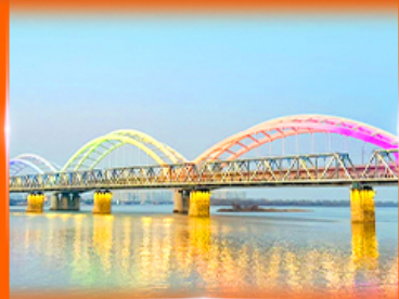
สะพานรถไฟปินโจว
