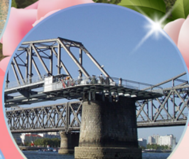
สะพานขาดตานตง
