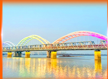
สะพานรถไฟปินโจว
