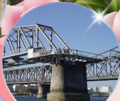
สะพานขาดตานตง
