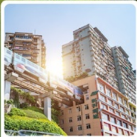
รถไฟฟ้าฉุดี้ก
