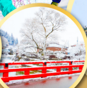
สะพานนากะบาชิ
