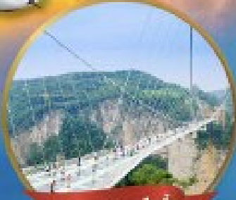
สะพานแก้วางเจียเจีย
