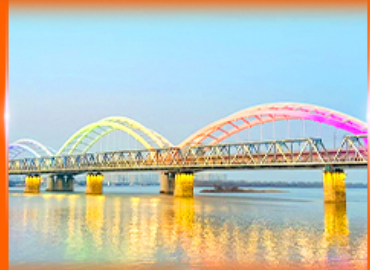
สะพานรถไฟปินโจว
