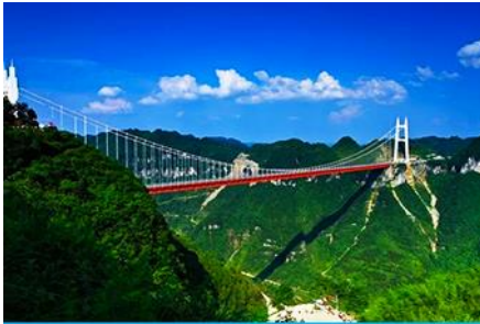
สะพาน ไร่จ้ายต้าเฉียว
