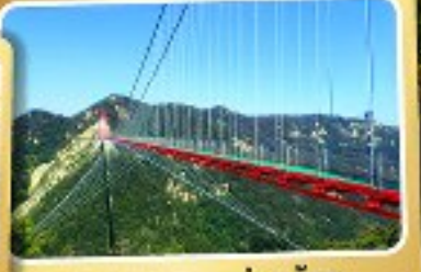
สะพานแวงอ้ายจ้าย
