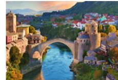
สะพานเก่า Mostar
