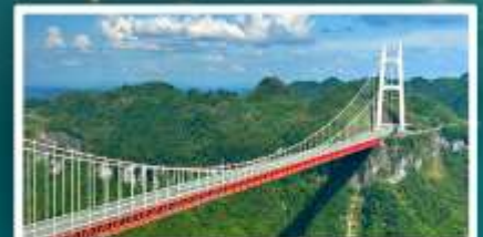
สะพานอ้ายจ้าย
