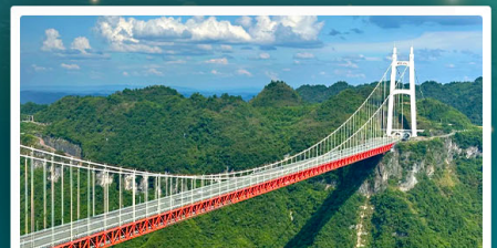
สะพานอ้ายจ้าย
