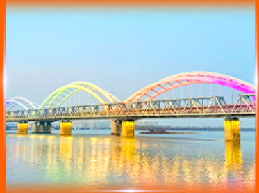
สะพานรถไฟปินโจว
