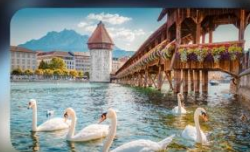
สะพานไม้ซาเปล
