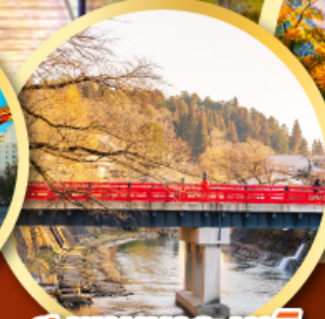
สะพานนากะบาชิ
