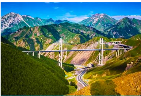
สะพานกั้วจื่อโกว
