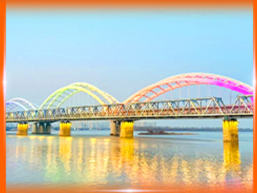
สะพานรถไฟปินโจว
