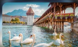
สะพานไม้ซาเปล
