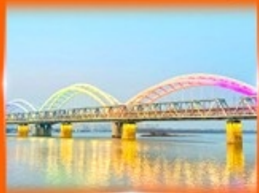
สะพานรถไฟผืนโจว
