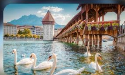
สะพานไม้ซาเปล
