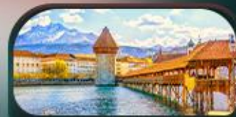
สะพานไม้อาเปิล
