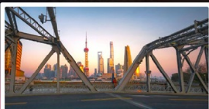
สะพานไวปี้ตู่
