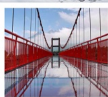
สะพานแก่วี่เสียง
