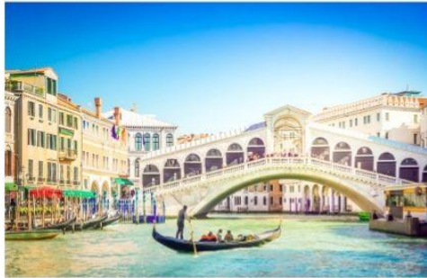
สะพานริอัลโต
