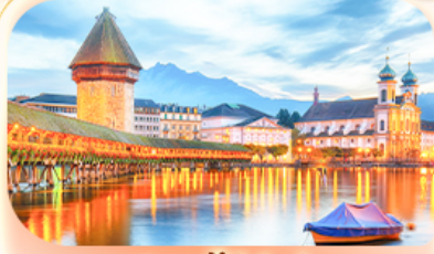
สะพานไมซ์าเปค
