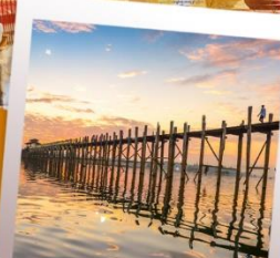
สะพานไม้จูปิง
