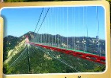
สะพานแวงอ้ายจ้าย
