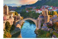
สะพานเก่า Mostar
