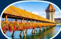
สะพานไม้อาเป
