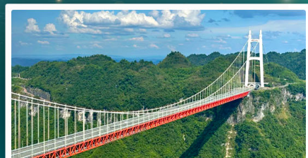
สะพานอ้ายจ้าย
