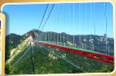
สะพานแขวนอ้ายจ้าย
