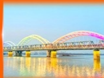
สะพานรถไฟผืนโจว
